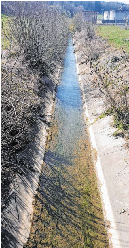
Im Rahmen einer Renaturierungsmaßnahme wird der Erlenbach im Bereich der Assamstadter Kläranlage auf einer Länge von mehreren hundert Metern zurückgebaut.
