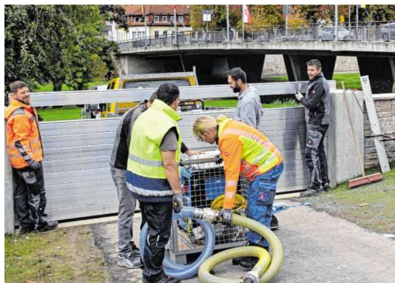
Die Aluminium-Elemente werden aufeinandergesetzt und dann festgespannt. Im Vordergrund eine der Gitterboxen, in denen für den Ernstfall mobile Pumpen und Stromaggregate verstaut sind.
