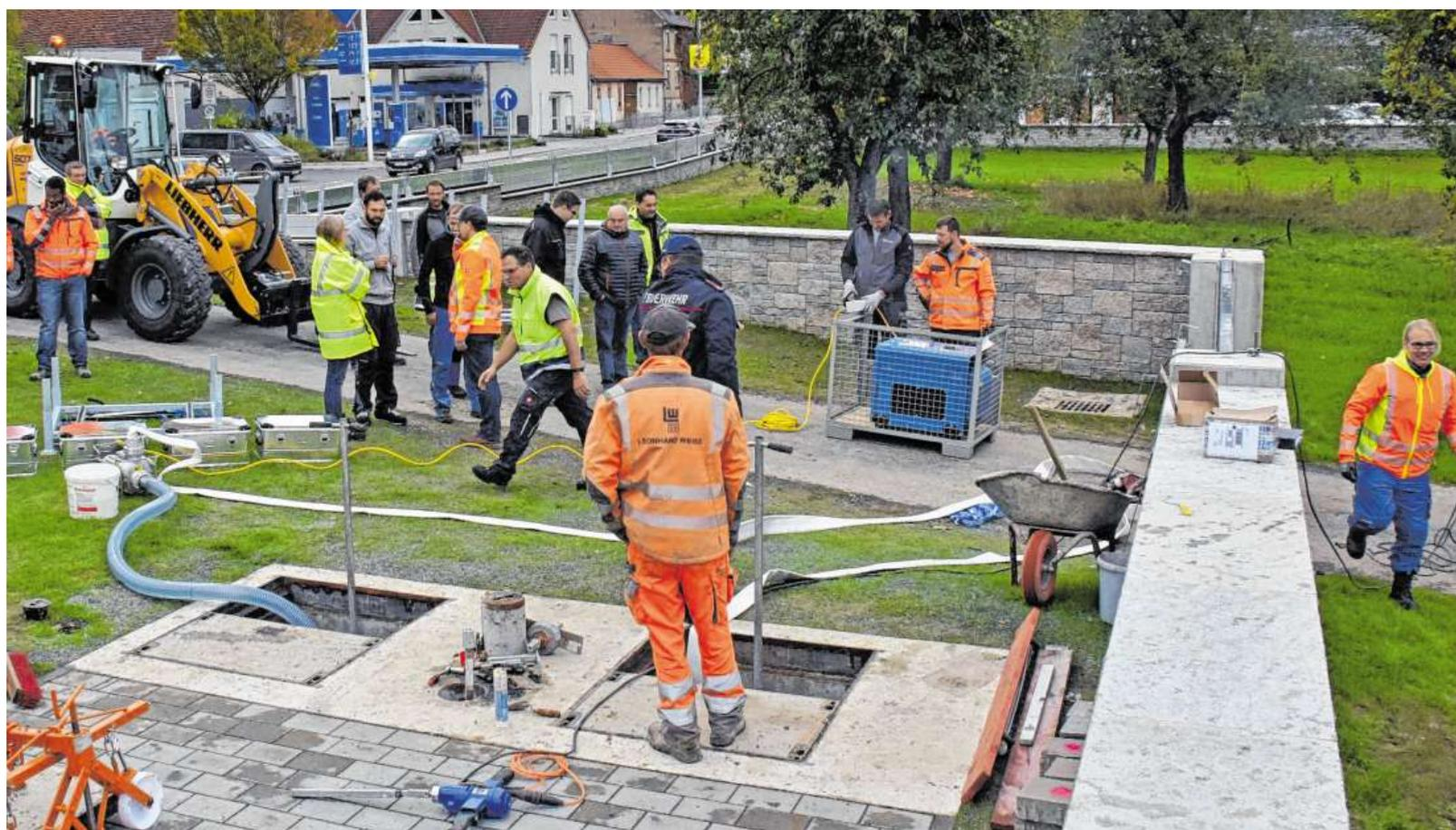
**Testlauf an der Tauberbrücke:** Mit vereinten Kräften wurden am Mittwoch die mobilen Hochwasserschutz Elemente erstmals eingesetzt und zusätzliche technische Hilfsmittel geprüft. In einem nächsten Schritt ist nun die Erstellung eines Einsatzplans vorgesehen.
